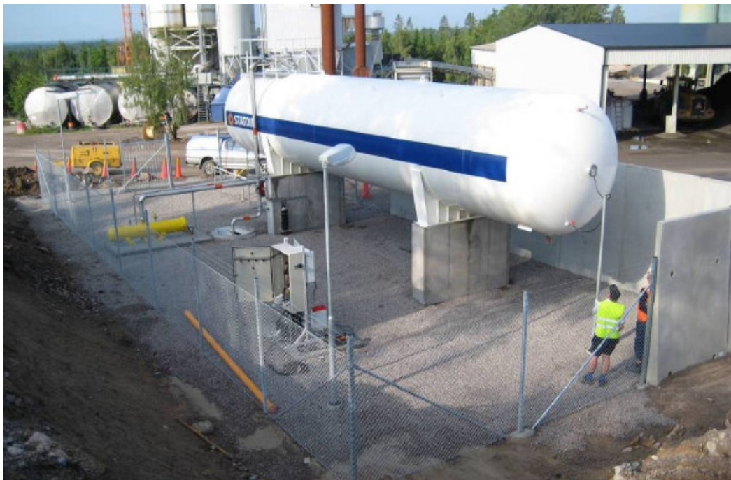
Figur 5. Gasoltank vid asfaltverk.
